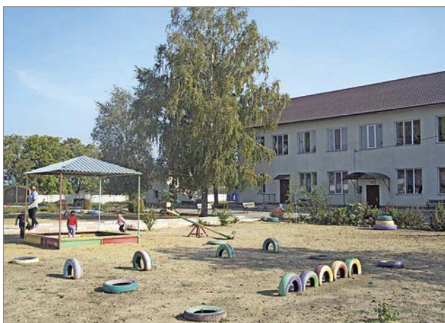
Відремонтоване приміщення Березанського дитячого садка «Берізка»
